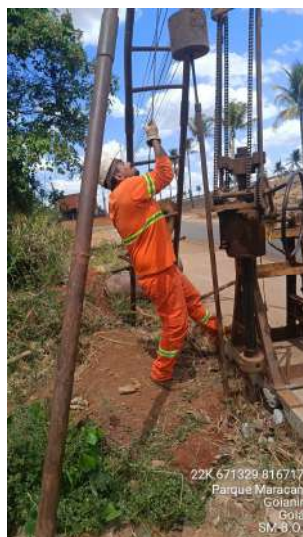
Foto 02 - Vista da execução da sondagem.
