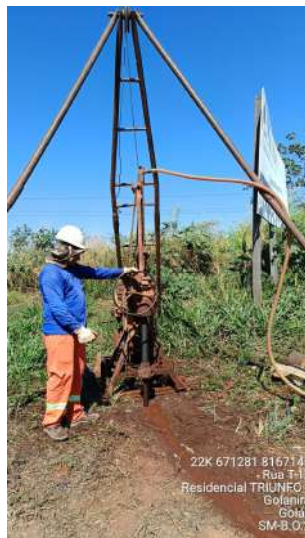
Foto 02 - Vista da execução da sondagem.
