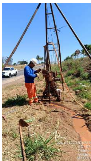
Foto 02 - Vista da execução da sondagem.
