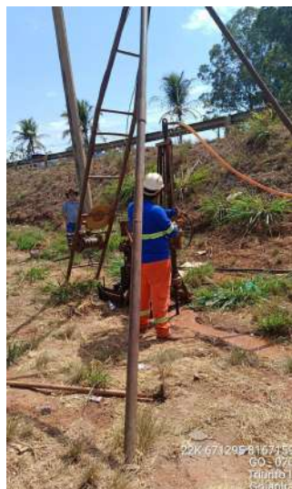
Foto 02 - Vista da execução da sondagem.
